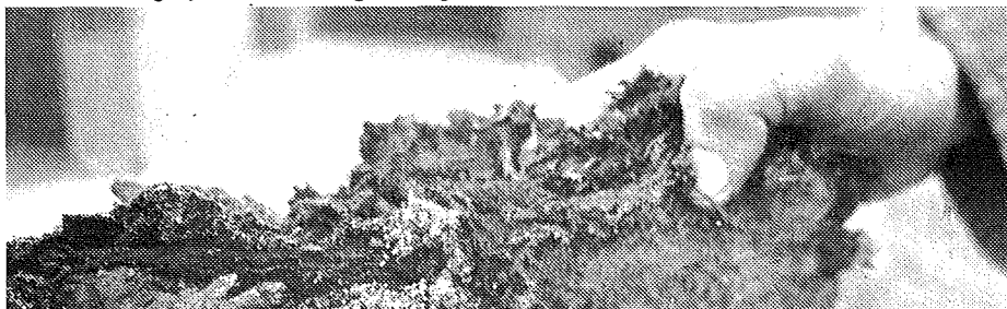
Tværværk hentet op fra et par meters dybde. Hvis ikke tværvet fjernes inden man bygger er der stor fare for, at jorden giver efter og synker noget, når først man har bygget.
