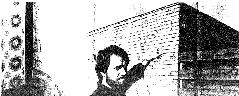
Fugten viser sig som sorte skjolder på den hvidmalede væg. Gavlaturene er begyndt at smuldre og kan i værste tilfælde falde ned, viser
